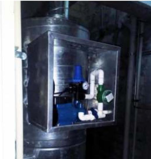
El rociado se lleva a cabo por una pistola especial que se activa con un timer programable para rociado de la solución cada determinado tiempo dependiendo de los volúmenes de desechos y la cantidad de pisos del edificio.
